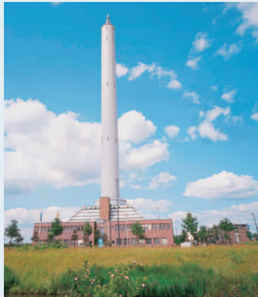
Im 146 Meter hohen Fallturm befindet sich ein Fallrohr für Versuche zur Grundlagenforschung
